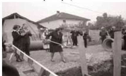
Почеток на изградбата
